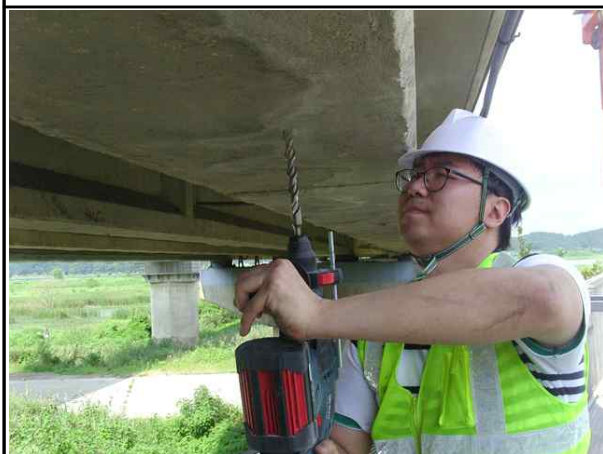
교량상부 외관조사 및 비파괴(2인 1조)
