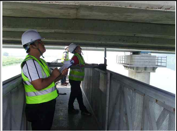
교량점검차를 이용한 조사
