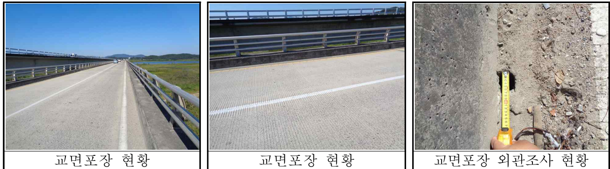
【그림 3.3】 교면포장 현황
