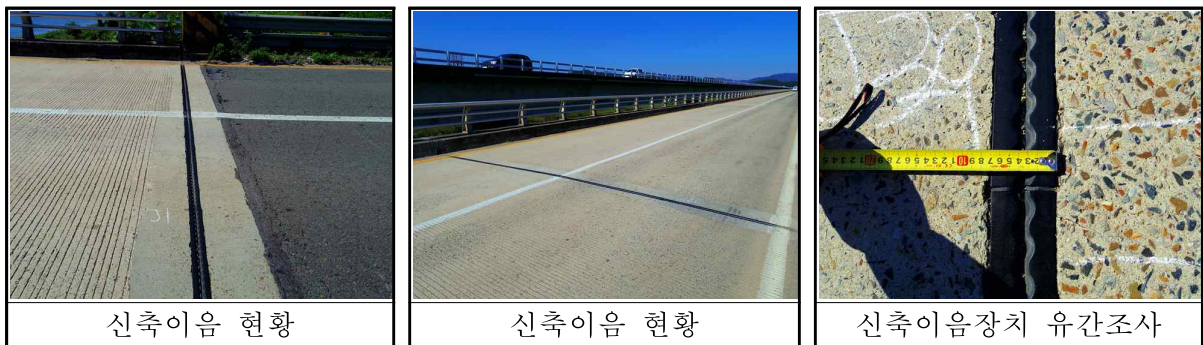
【그림 3.22】 신축이음장치 현황 및 외관조사
